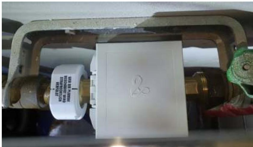
Foto einer Wasserzählerbrücke mit elektronischen Smartmeter-Wasserzähler
